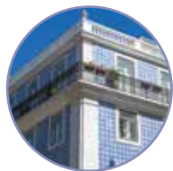
Calçada e Azulejos
